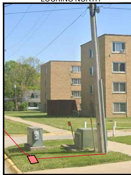
HH5 - ICN STA. 46+42
