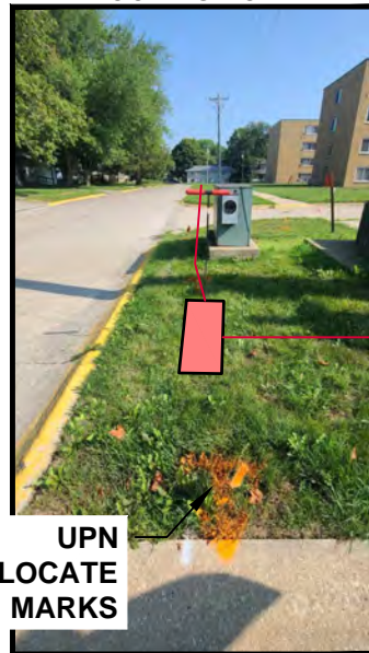
HH5 - ICN STA. 46+42
