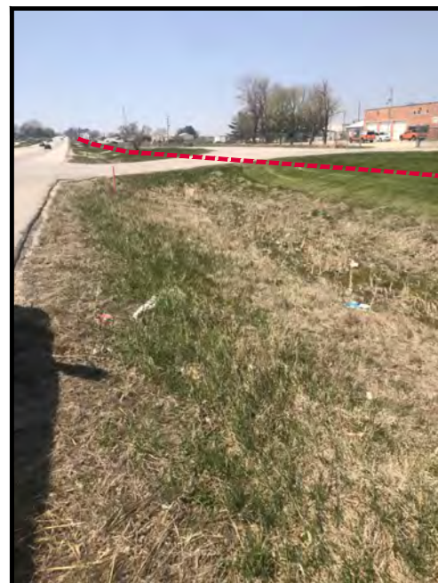
HH8 - ICN STA. 68+06
