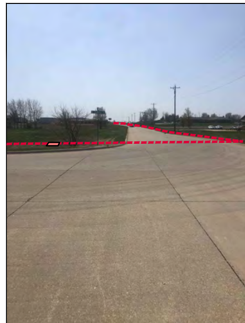
HH10 - ICN STA. 100+07
