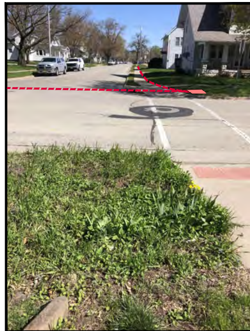
HH2 - ICN STA. 6+42
