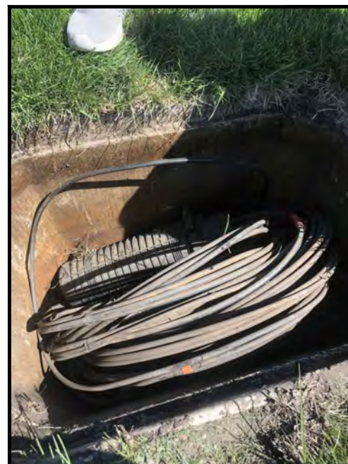
HH6 - ICN STA. 53+98
