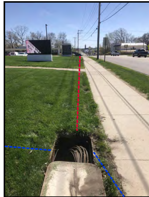
HH6 - ICN STA. 53+98
