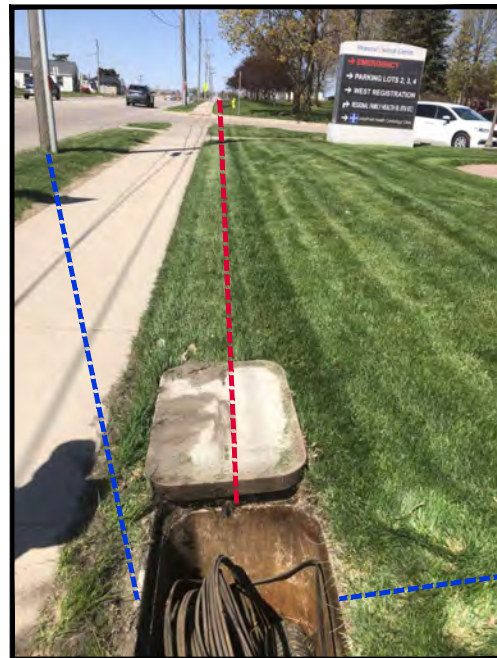
HH6 - ICN STA. 53+98
