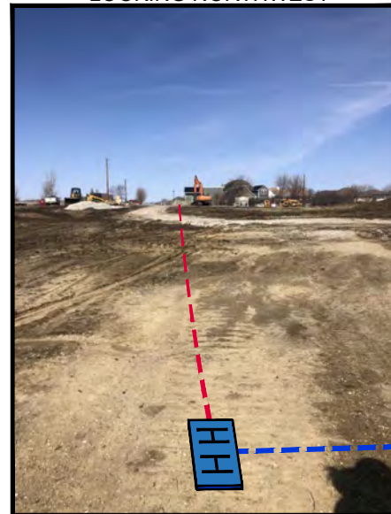
HH5-EX BCSD STA. 52+72
