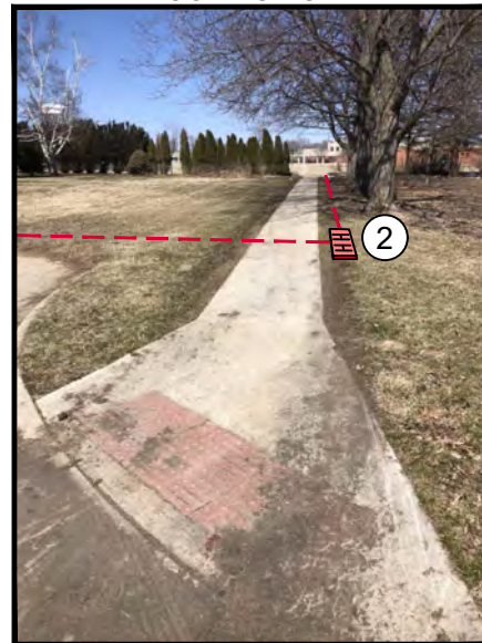
HH2 - BCSD STA. 12+90
