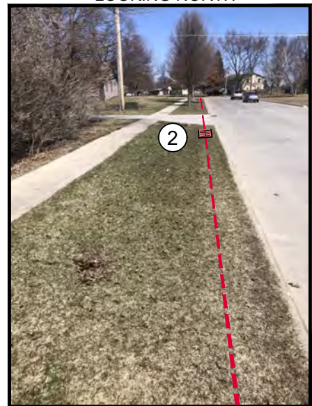
HH3 BCSD STA. 25+41
